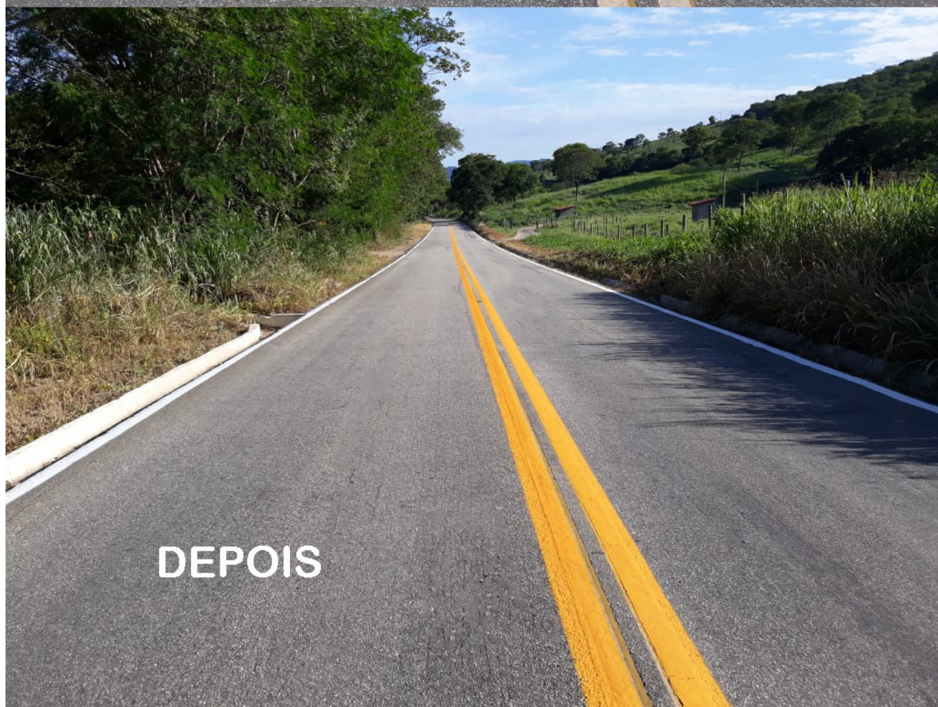
A MG-406, o trecho de 36,6 km de extensão entre Rio do Prado e Rubim foi um dos contemplados. O
